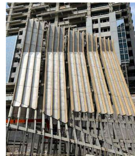
▲利用 BIM 進行教堂施工檢討
